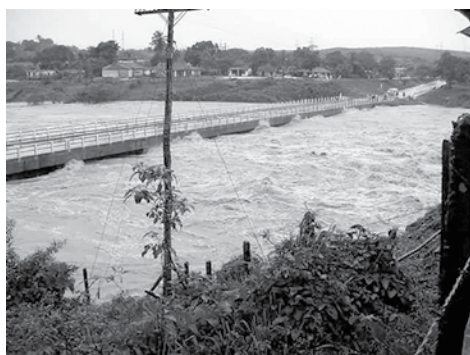
Figura 1.3: Avenida del río Zaza a la altura del asentamiento Zaza del Medio con las lluvias intensas del año 2002, Sancti Spíritus.
